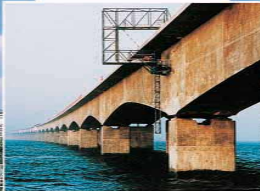
Storebælt west bridge (DK)
